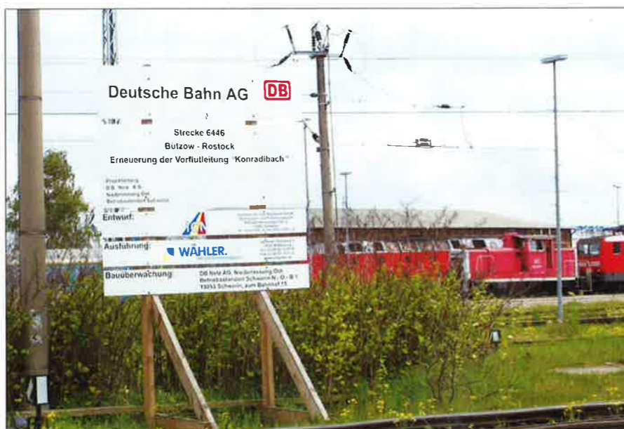
Dank Mikrotunnelbau blieben der Deutschen Bahn AG enorme Finanz- und Imageverluste erspart!
