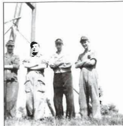
In der Nachkriegszeit leisteten die Mitarbeiter im Freileitungsbau echte Knochenarbeit.
