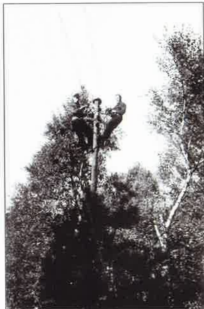
Körperliche Höchstleistungen erforderte die Arbeit im Freileitungsbau Ende der 60-iger
