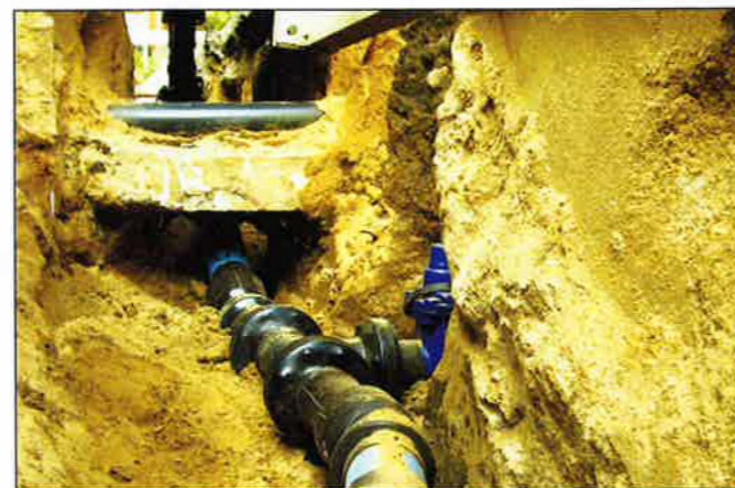
Frisch eingebaute Schieber.
