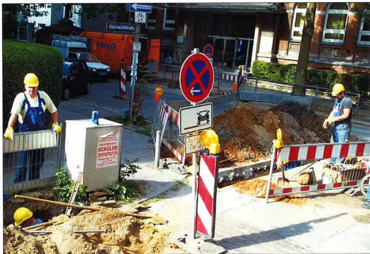
Enge Bebauung, Parkplatznot: Trotz der "sparsamen" Anwendung der offenen Bauweise, mussten in Eimsbüttel teilweise täglich bis zu 28 Autos abgeschleppt werden.
