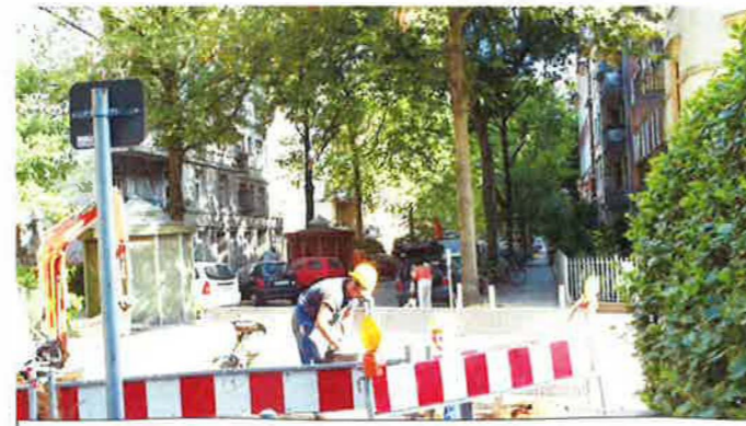
Das Team von Kolonnenführer Thomas Tödter stellt einen Rohrgraben her.
