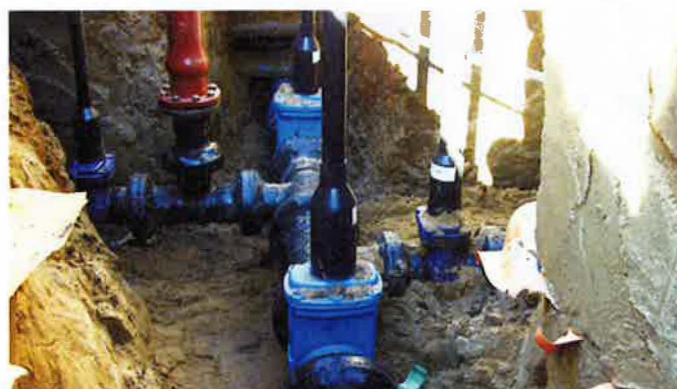
Herstellung eines Schieberkreuzes.
