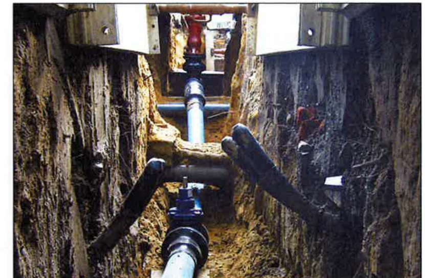
Diese Stahlrohre mit Zementauskleidung und PE-Umhüllung wurden in Eimsbüttel verlegt.
