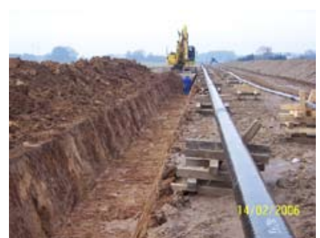
Erstellung Rohrleitungsgraben
