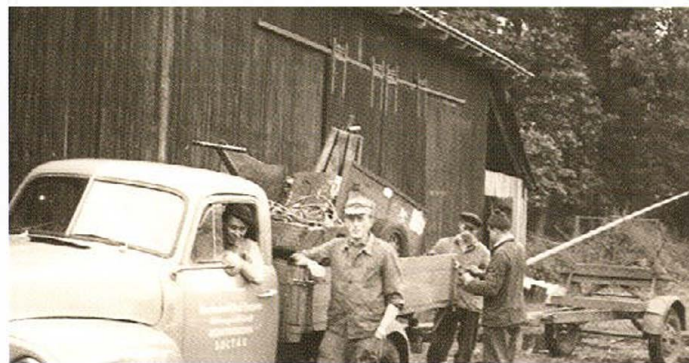
Mitarbeiter der ÜNH unterstützen beim Umsetzen auf neue Baustellen
