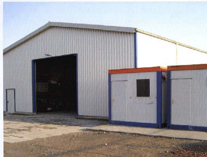
Die neue Lagerhalle auf dem 4000 m 2 großen Bauhof
