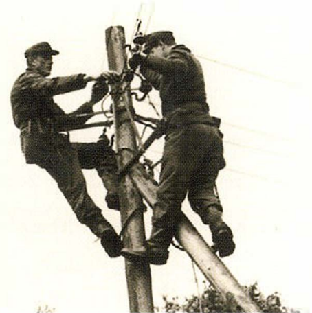
Arbeiten in luftiger Höhe gehörten zum Alltag im Freileitungsbau
