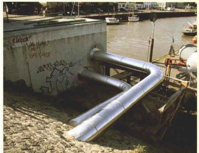
Vor- und Rücklaufstrang der Fernwärmetrasse treten ins Dükeroberhaupt der Kennedybrücke ein.
