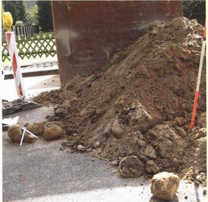
Steine mit einem Durchmesser von bis zu 50 cm erschwerten die Bohrarbeiten
