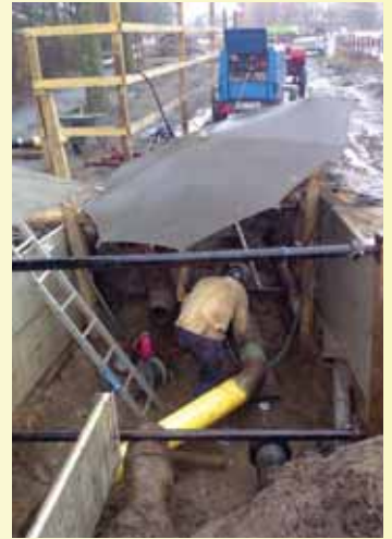
Schweißarbeiten Gasleitung DN 200 StPE
