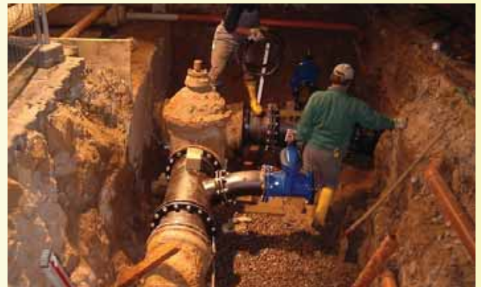
Hydromatenwechsel DN 600 in Nachtschicht
