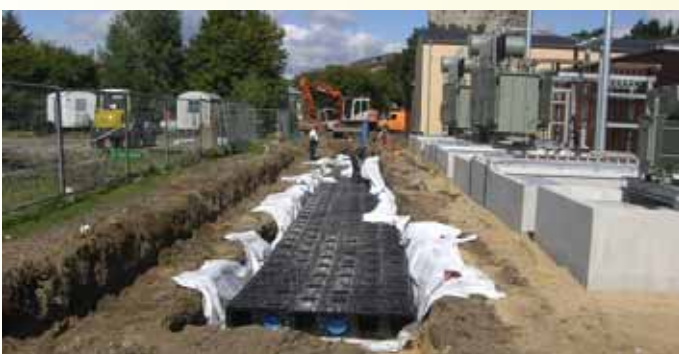
Kanal- und Oberflächenarbeiten auf dem Umspannwerk Wasserturm
