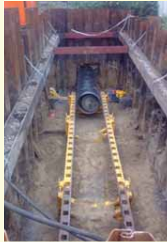
Stahlrohrpressung DN 600 am VW-Werk in Hannover-Stöcken
