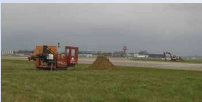
Trinkwasserleitung im Spülbohrverfahren während Startbahnspernung auf dem Flughafen Hannover-Langenhagen
