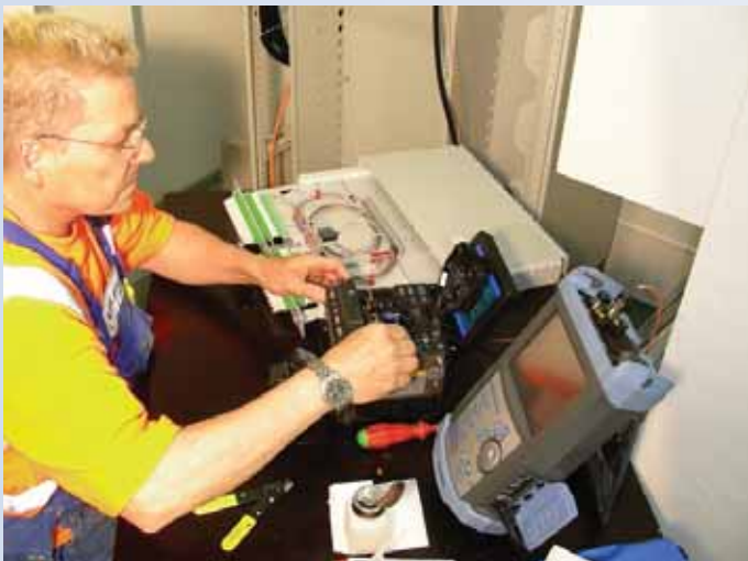
Spleißarbeiten Montage Außenkabel an Spleißbox
