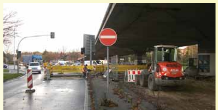
Erneuerung einer Gasleitung unter dem Messeschnellweg
