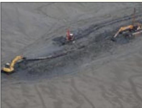
**Abwasserdruckrohrleitung für die
