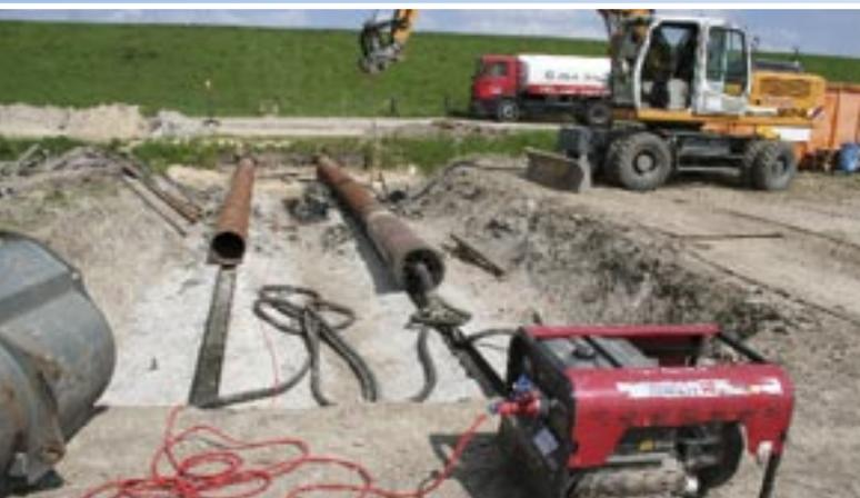
*Gut im Zeitplan wird mit der Deichquerung mittels Stahlrohrrammung begonnen.*
