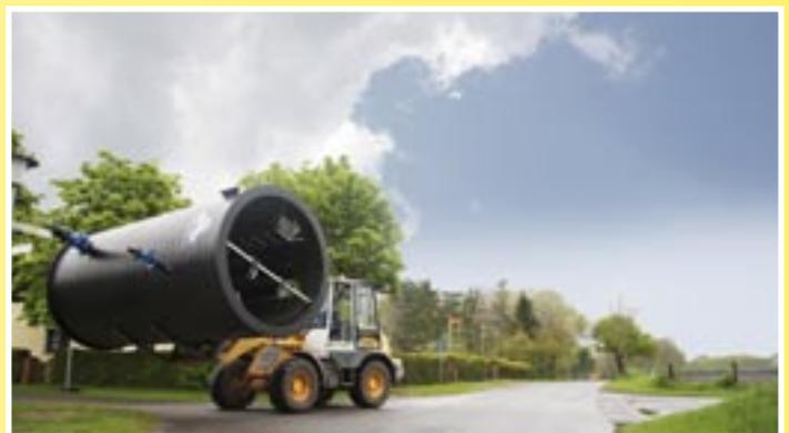
Beim Einbau des Pumpwerkschachts entstand durch die talähnliche Lage sehr viel Grundwasser. Um das anstehende Wasser abzusenken, wurden zwei Vakuumpumpen benötigt und 12 Filter eingebaut. Im unteren Bereich des Schachtes wurden 3,0m<sup>2</sup> Beton mit Stahlband eingebaut, um ihn aufgrund des anstehenden Wassers gegen Auftrieb zu sichern.
