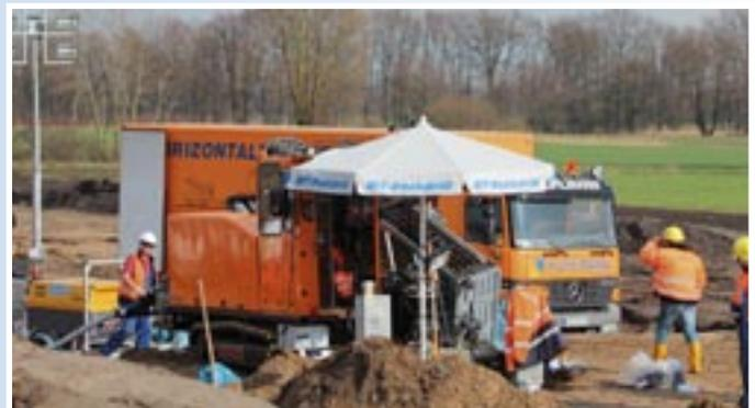
240 PS Deutz-Diesel, Bentonitspülung 520 Ltr./min bei 65 bar, 300 KN Zugkraft; 13.500 Nm Drehmoment
