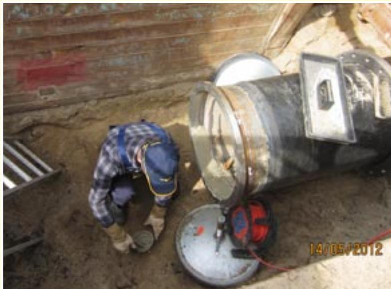
*Zementauskleidung Flansch DN 600*
