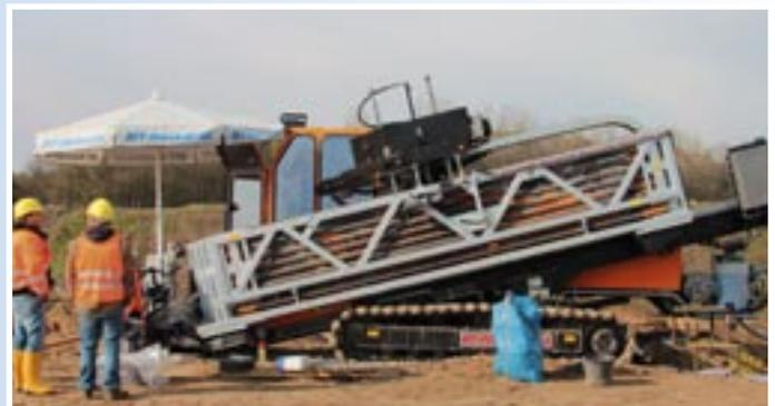
228,5 m Bohrstangen im Magazin
