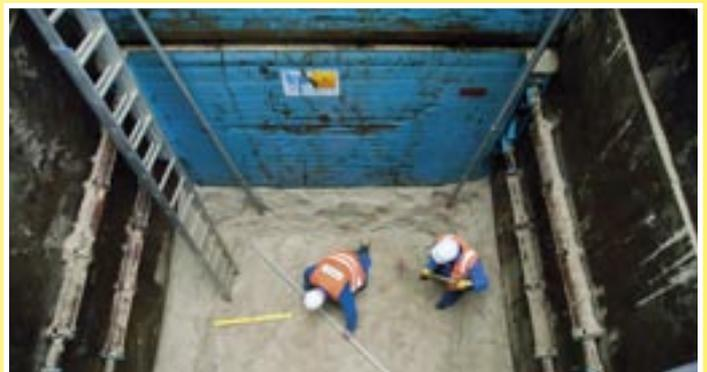
Die aus dem Pumpwerk führende Druckrohrleitung DA 75 mm wird an die bereits im letzten Jahr verlegte Leitung Kreppe - Midlum angeschlossen.
