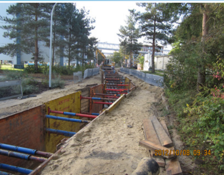
Verbauter Rohrgraben auf der Baustelle DESY in Hamburg zur Verlegung von Fernwärme- und Fernkältesystemen
