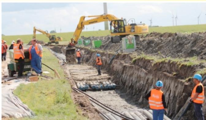
Schutzrohre in einem offenen, geböschten Graben mit 3m Sohlbreite und 1,75m Sohltiefe mussten knapp 40.000 m<sup>3</sup> Boden bewegt und 81 Horizontalbohrungen durchgeführt werden.
