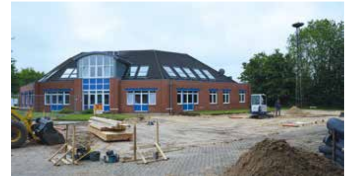
Die Ausmaße des Anbaus werden sichtbar. Die Familie Storch beobachtet von Ihrem Aussichtsposten aus ganz genau die Bauarbeiten.
