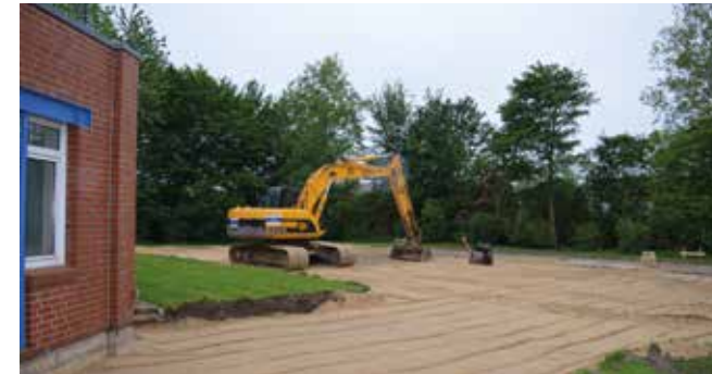
Dorum. Mai 2016: Die Vorarbeiten laufen an. Wo vorher Rasen und Teile des Parkplatzes waren, leuchtet jetzt heller Sand.
