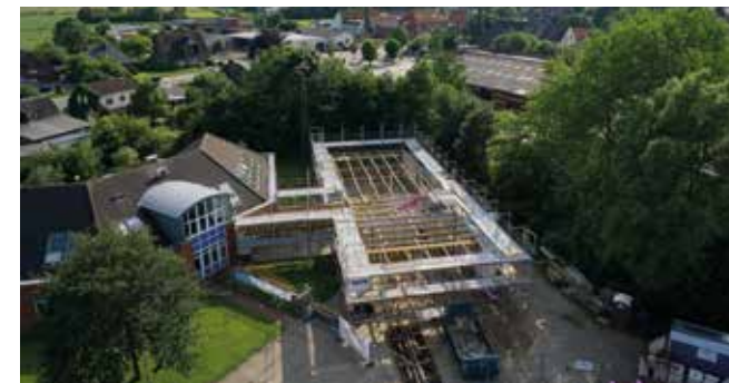
Der Blick von oben zeigt die Dimensionen des Neubaus: Der Übergang zwischen Alt- und Neubau sowie die rechteckige Form sind bereits klar erkennbar. Die Bauarbeiten schreiten zügig voran.
