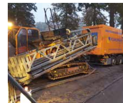
Bohranlage samt Technik
