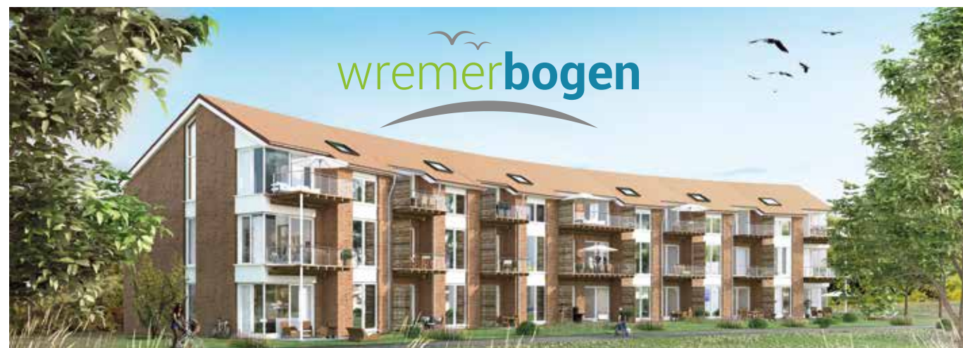
Das neue Apartmenthaus in Wremen - der Wremer Bogen
