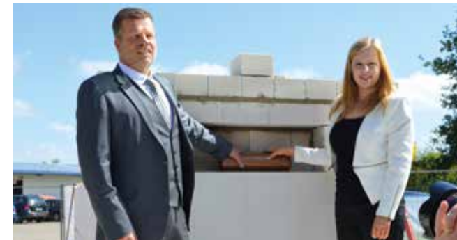
Juni 2016: Den Grundstein legen Ulrich und Tessa-Thalea Seier bei bestem Wetter - ein gutes Zeichen für die Bauarbeiten. Der Stolz auf den Erweiterungsbau ist in den freudigen Gesichtern zu lesen.
