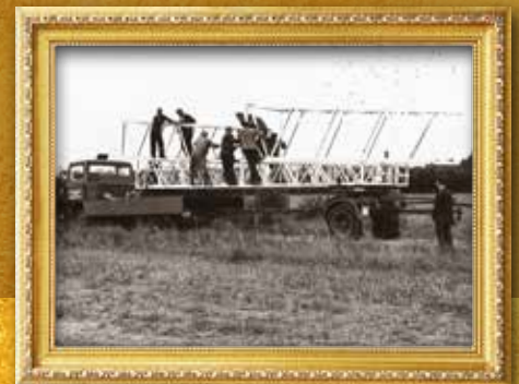
Versammelte Mannschaft: Abladen der Gittermastenelemente.
