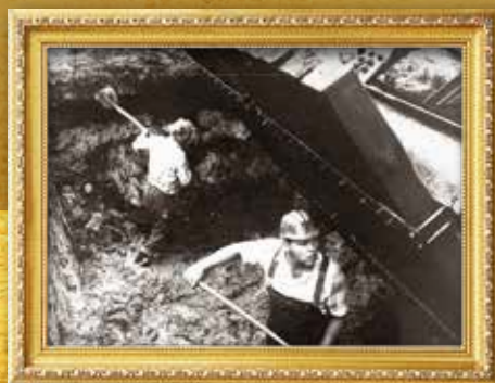
Bei matschigen Bodenverhältnissen musste das Fundamentloch immer wieder freigeschaufelt werden.
