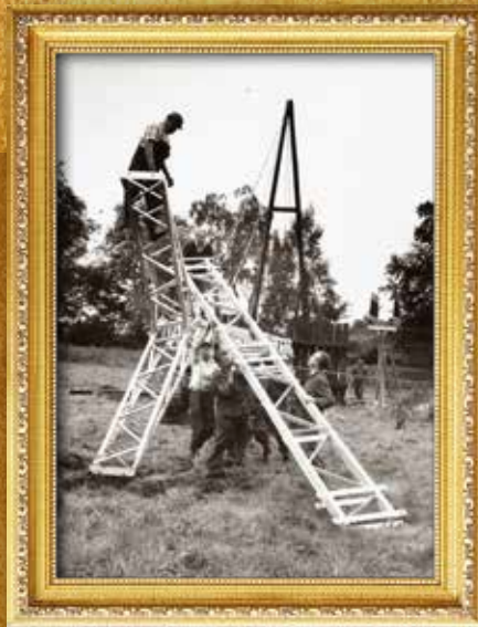
Von wegen Kran: Montage und Aufstellen der Freileitungsmasten von Hand.
